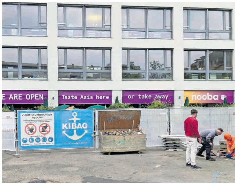
Baustellen (wie hier beim nooba) sind schwer verdaubar für betroffene KMU.
